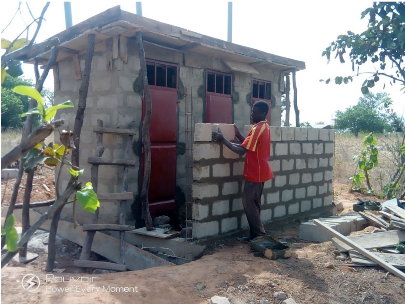
Latrines du collège de Nagayilé en voie d'achèvement, décembre 2021
